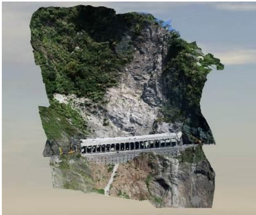
圖 6 施工前 ContextCapture Center 建模
