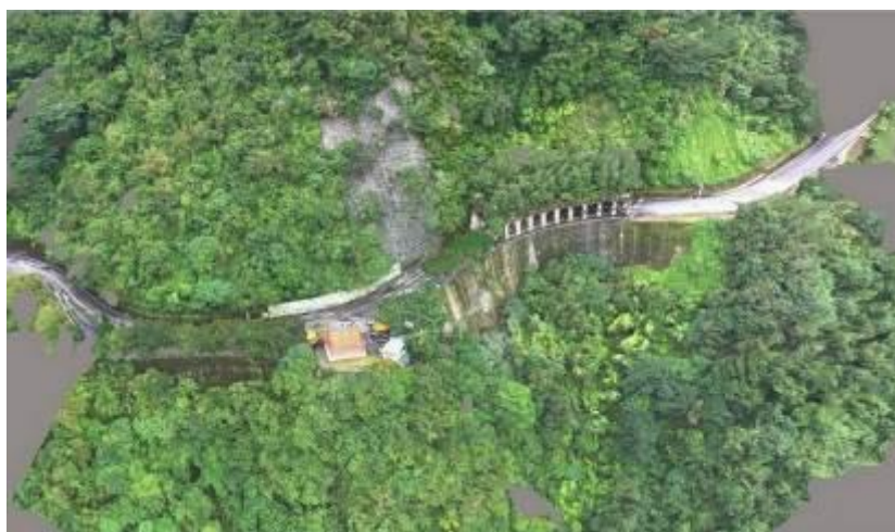
圖 2-1 台 9 丁線 13K+945 災害後 3D 建模(資料來源:交通部公路總局四工處南澳段)
