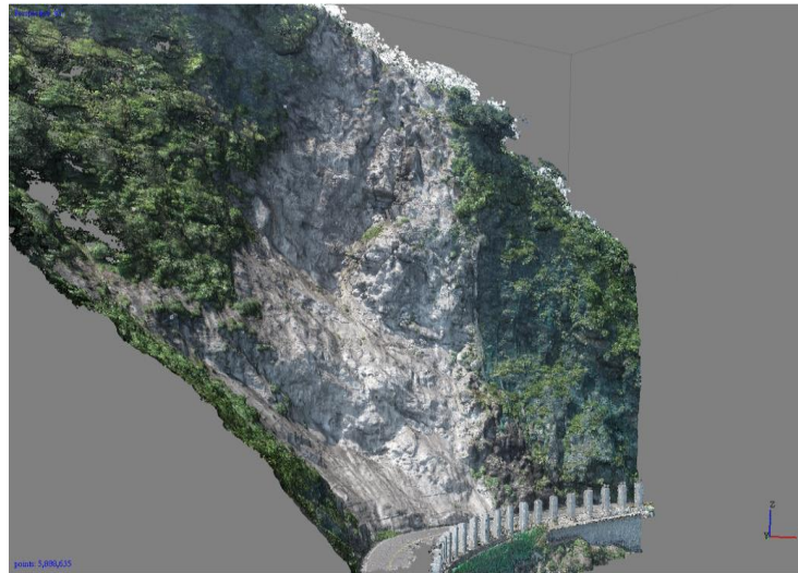
圖 5 施工前 ContextCapture Center 建模
