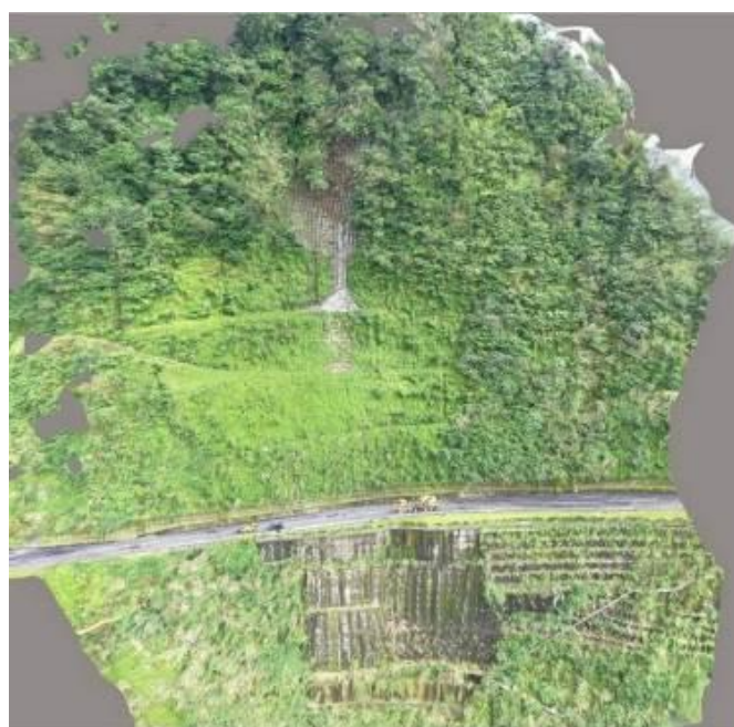
圖 2-2 台 9 丁線 13K+082 災害後 3D 建模(資料來源:交通部公路總局四工處南澳段)
