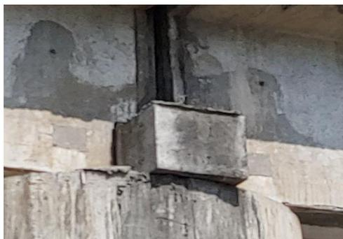
圖3.4-2 縱向梁端防落長度
