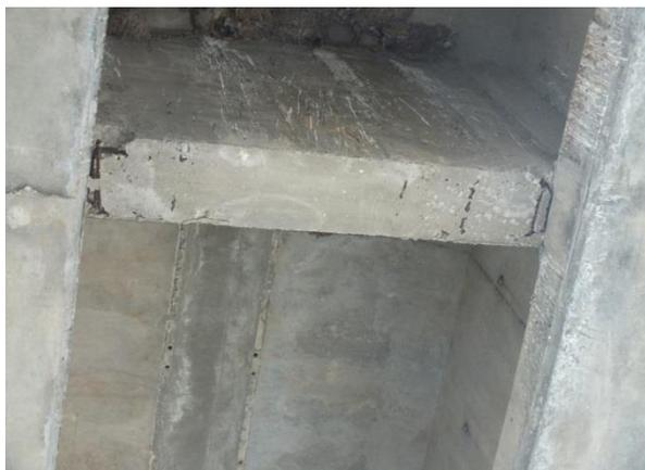
圖2.1-4 梁之橫隔梁底面鋼筋裸露輕微生鏽。
