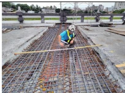
照片 3.1 鉸接板鋼筋綁紮
