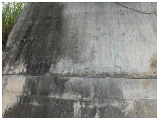
圖2.1-9 A2橋台之正面有水平裂縫，可能是鋼筋生鏽所造成
