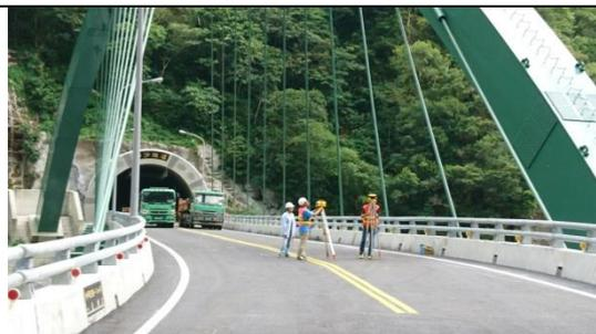
照片 2.12 卸載留置 2 部卡車在橋梁上。
