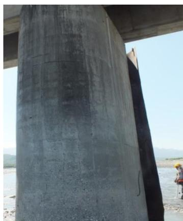
圖2.1-6 橋墩有縱向及橫向裂紋，箍筋裸露生鏽，防撞鋼板鬆脫。
