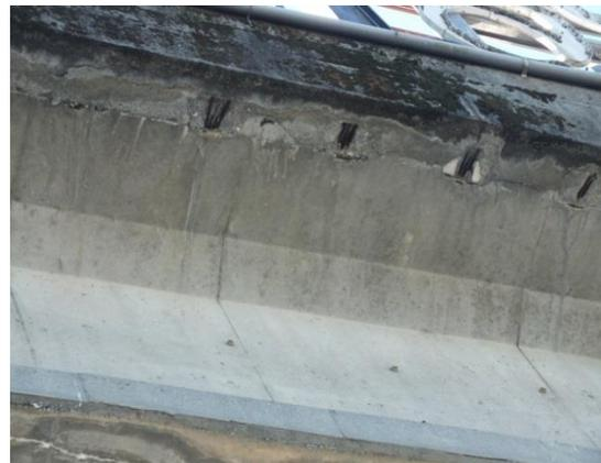
圖2.1-3 梁上翼板之下緣鋼線裸露生鏽
