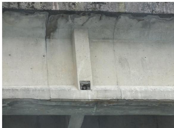
圖2.1-5 梁上翼板之下緣鋼筋裸露生鏽，橫隔梁處鋼線裸露生鏽
