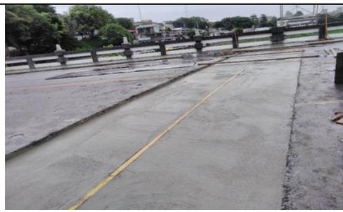
照片 3.2 鉸接板澆置混凝土完成後，在中央放置三角型木條，形成 V 型凹槽。
