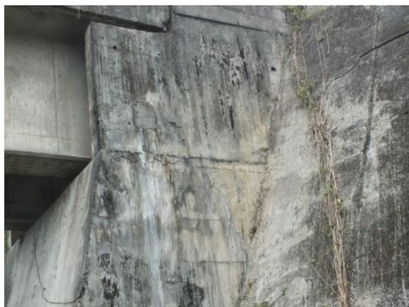
圖2.1-8 A2橋台之南側夾牆有裂紋，翼牆有水平裂紋
