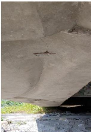
圖2.1-2 縱向裂紋或鋼筋少部分裸露生鏽
