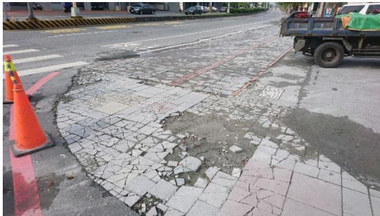
圖1 步道鋪面磚破壞
